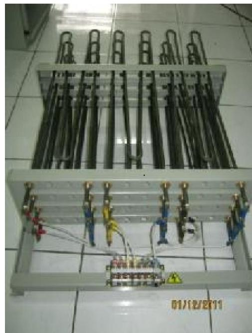
Ce rack de résistances peut être un réchauffeur de chauffage central, un gros cumulus, un réchauffeur de piscine,..... le seul impératif est qu'il ne soit pas régulé afin de toujours pouvoir dissiper l'énergie non consommée par le circuit d'utilisation.
